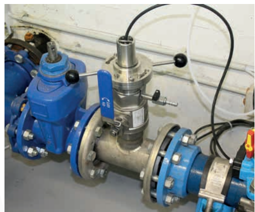
Montering av Turbimax CUS52D på ledning.
